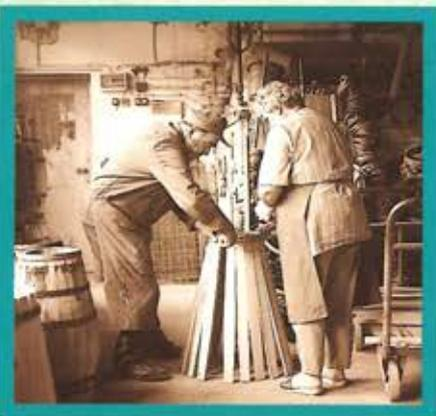
Basis zur Herstellung unserer Kessel sind diese perfekt abgelagerten und selektierten Hölzer, aus denen massive Daubenrohlinge gesägt werden. Diese Rohlinge werden dann auf einer speziellen Fräse zu fertigen Dauben verarbeitet.
